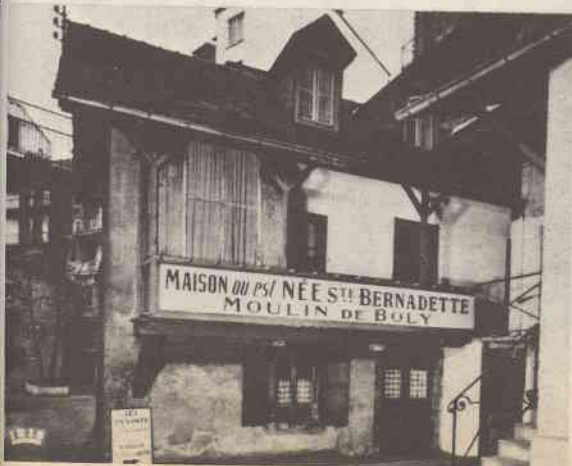
▼右の家屋は現在このように修復されている。
