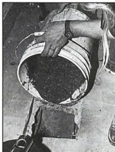
Pourin' the cement.
